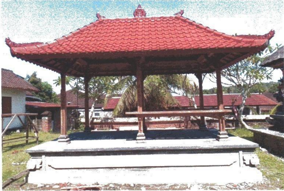
FOTO SETELAH DIREHABILITASI BALAI PIASAN PURA PEMAKSAN
